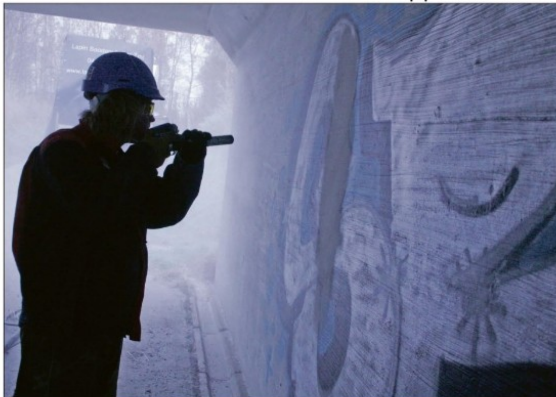
Lapin Soodapuhalluksen yrittäjä Mika Tikkala puhdisti Peurasaarella moottoritien uusiin alikulkutunneleihin tehtyjä graffiteja.
